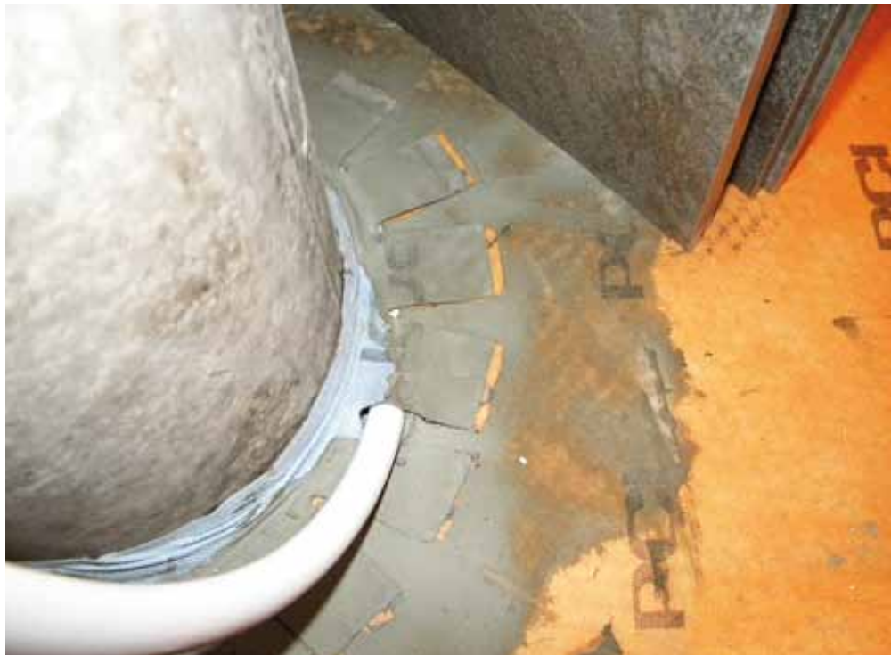
Missglückte Einbindungen einer Stahlbetonstütze mittels Butylkautschuk-Band auf einer Abdichtungsbahn.
