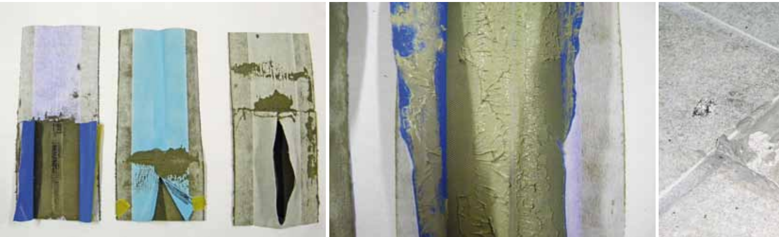
Begrenzte Adhäsionshaftung in der Überlappungszone der Abdichtbänder.
